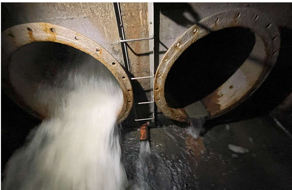
Obrázek 12: Pohled z povodní strany na zaústění SV do odtokové štoly. Zaústění výtoku z MVE bude ve středu u dna.
