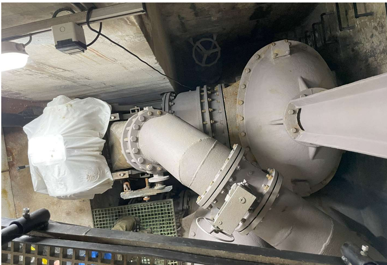
Obrázek 8: Pohled shora, pod plachtou je stará, původní Bankiho turbína.
