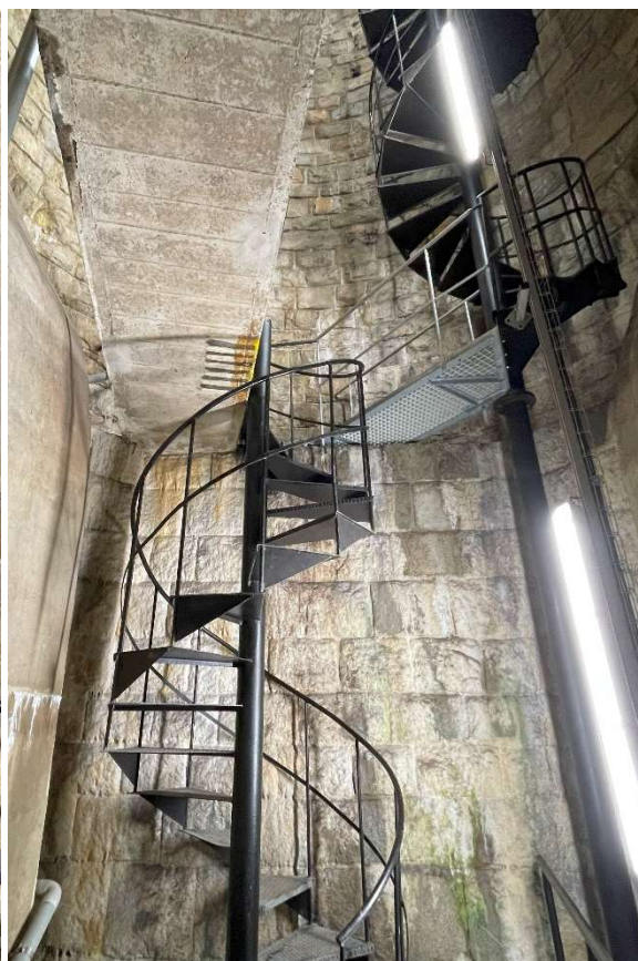
Obrázek 5,6: Vlevo: pohled na rozebíratelné podesty, které je možno pro manipulaci odstranit. Vpravo: pohled na schodiště a betonovou lávku z pohledu od spodních výpustí.
