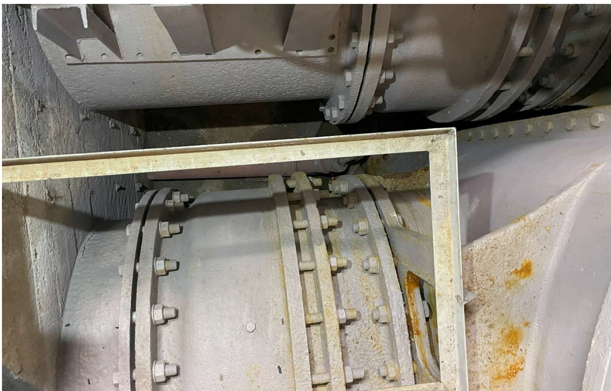
Obrázek 10: V tomto prostoru mezi potrubími SV bude při podlaze situována savka turbíny a prostup betonovým blokem. Na snímku je odstraněná podesta, která bude v projektu posunuta a předělána.
