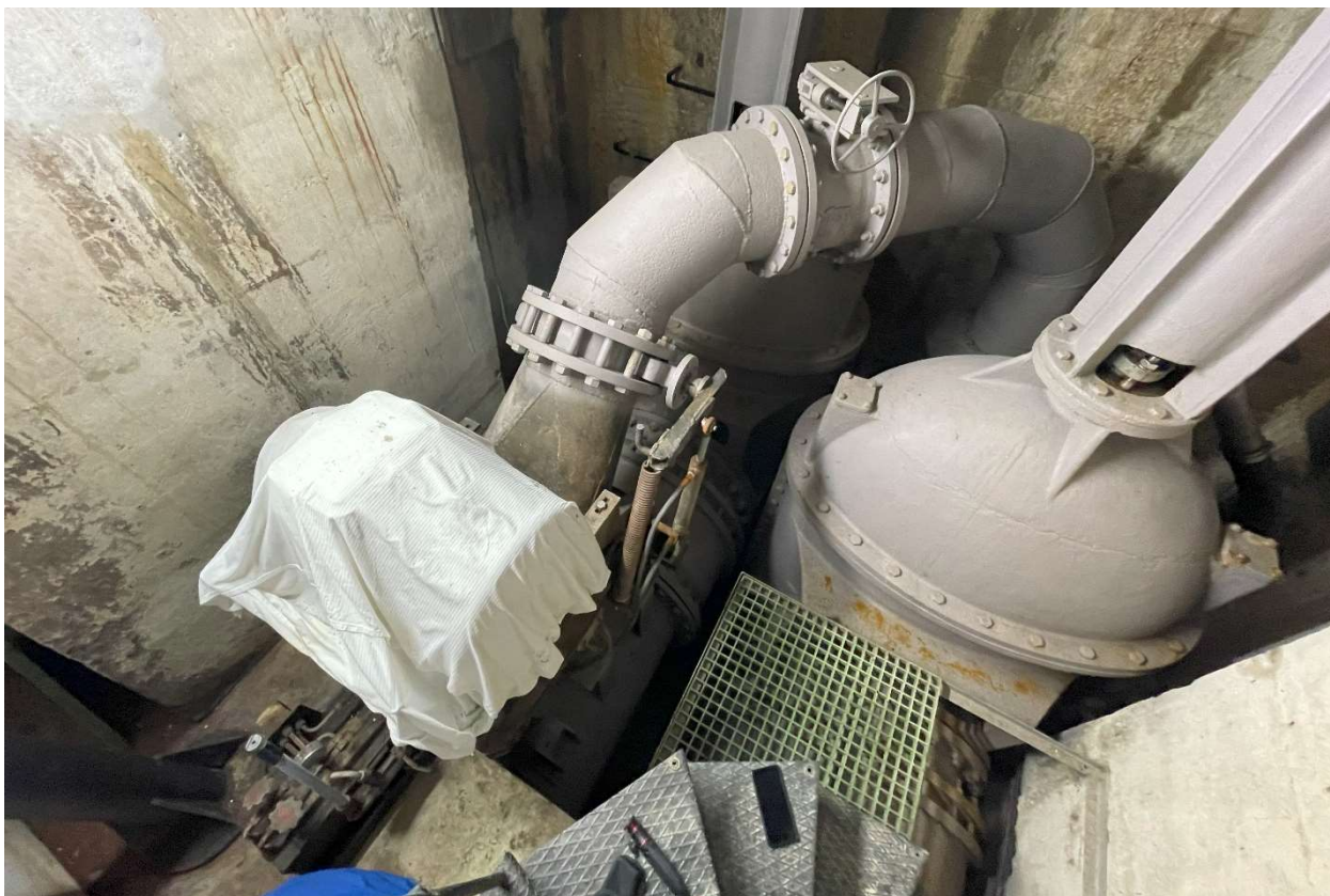
Obrázek 7: Pohled na potrubí obtoku uzavěru spodní výpustě, který slouží k převádění MZP.
